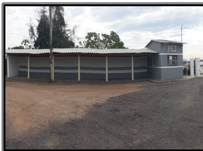
Reforma do abrigo para visitantes.
